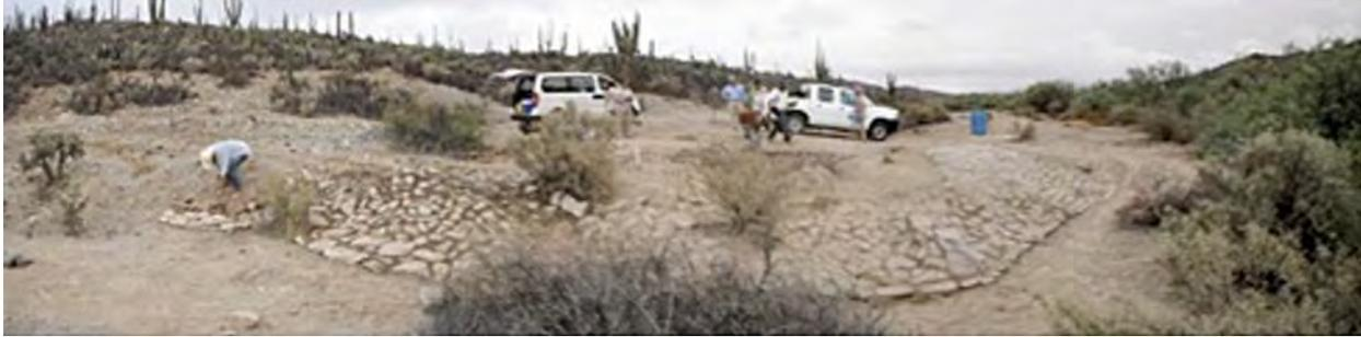
Figura 14. Construcción de muro de contención para evitar erosión hídrica.
